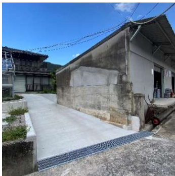
▲新設した土木部門の施工事例
